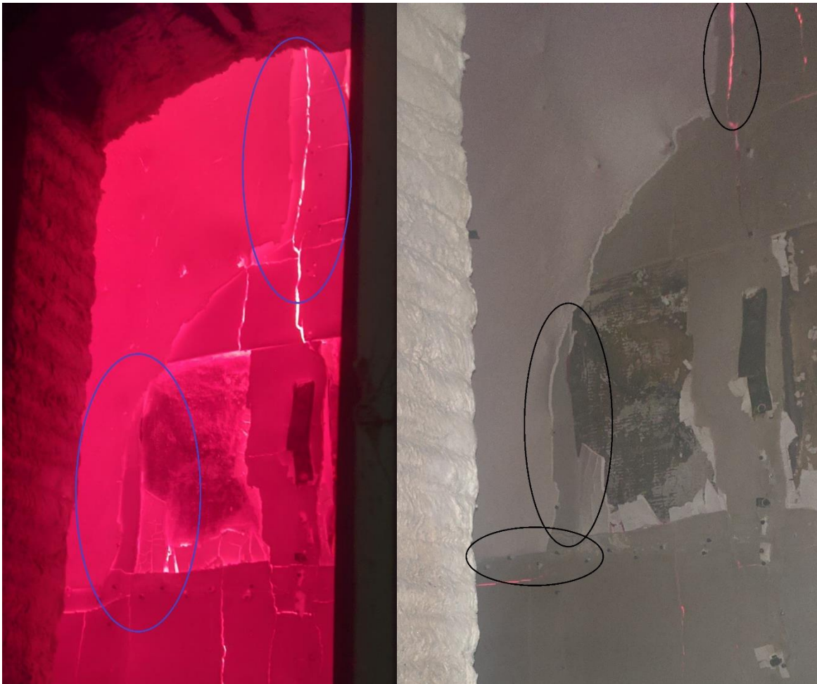
Рис. 3.11 При испытании трещины образовались от мест, утопленных в обшивные материалы саморезов, сами трещины идут вдоль линии скрепления и обшивной материал выпадет одним блоком.
