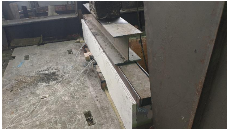
Рис. 3.7 Образец изготовлен без зазоров, нагрузка от нагружающего элемента идёт на обшивной материал, создавая избыточное напряжение на крепёжных элементах.
