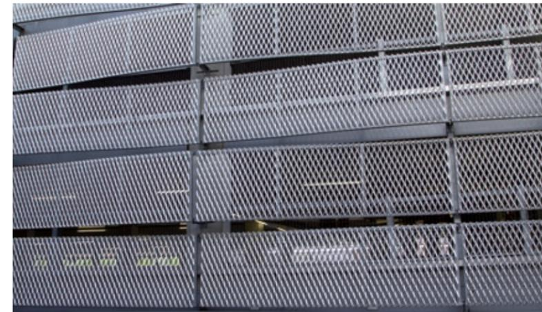
Рисунок 3.6 Пример решения фасада с панелями из сетки
