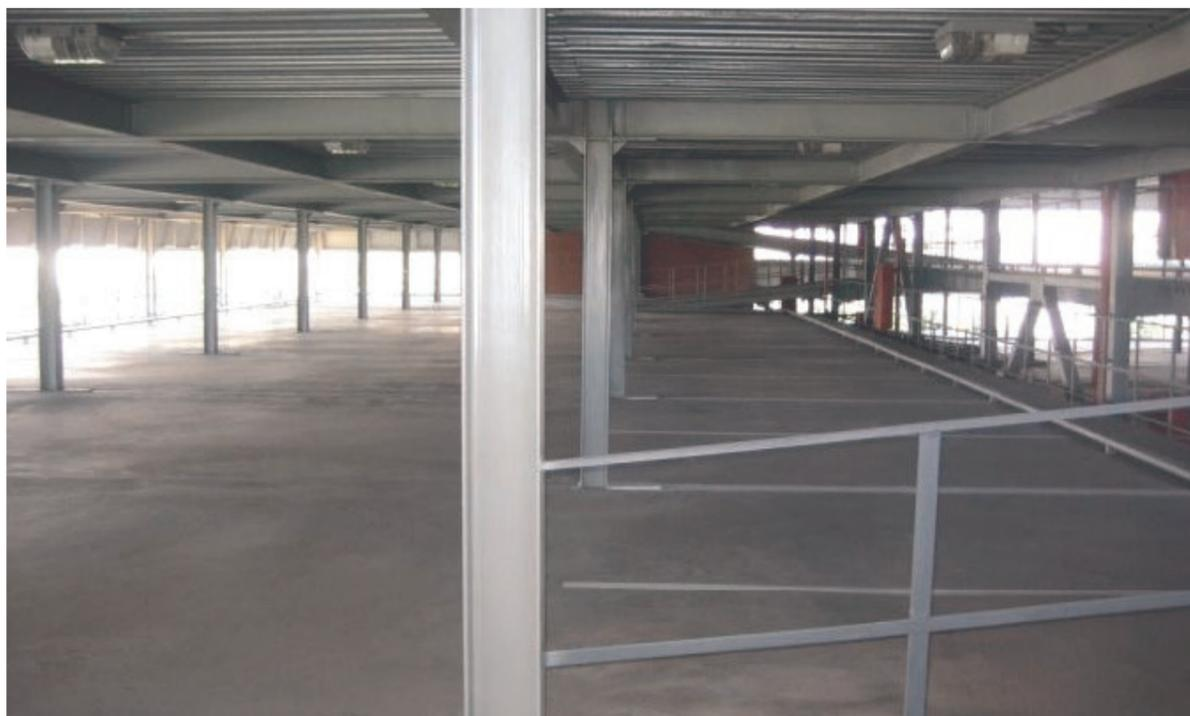
Рисунок 2.4 Гараж-стоянка с двумя дополнительными колоннами в пролете (Москва, Филевский бульвар, 1, компания «К-Проект»)
