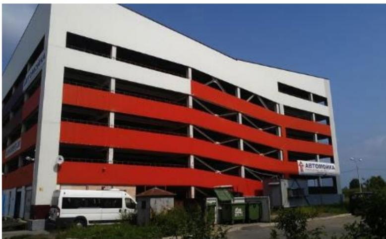
Рисунок 3.2 Пример открытого гаража-стоянки с ограждением в виде парапета в Череповце.
