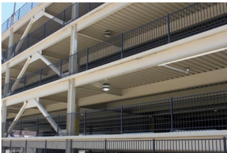
Рисунок 3.1 Пример металлического ограждения
