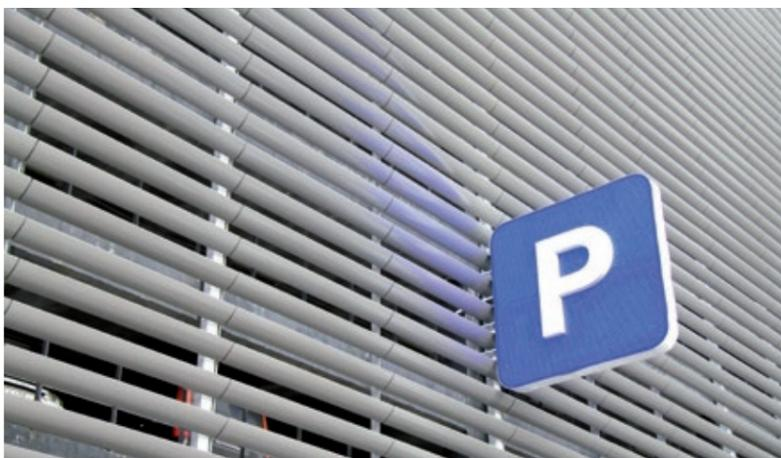
Рисунок 3.7 Пример решения фасада из металлических жалюзи
