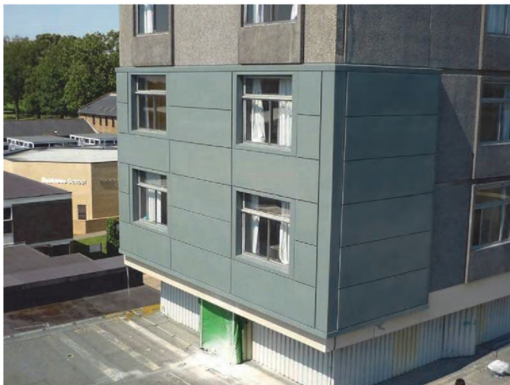
Рис. 3.13. Готовый новый фасад на двух первых этажах выше стилобата, август 2009 г.
