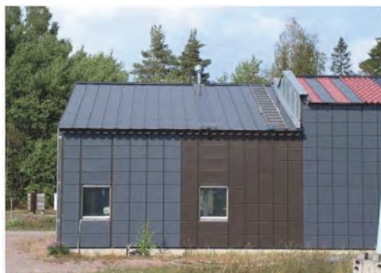
Здание с крышей VTT. Уклон крыши составляет примерно 30°, на южной стороне. Воздушные каналы в профилированном листе.
