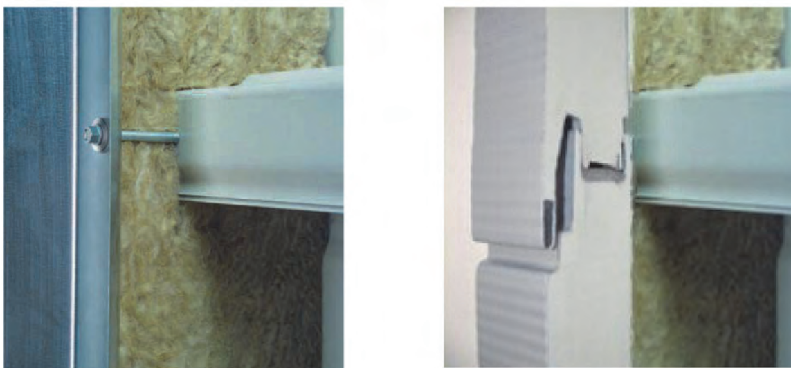
Рис. 4.6. Установка фасадной системы с заменой старого фасада и монтаж дополнительного слоя теплоизоляции (плита Steelrock компании Rockwool, слева), установка новой фасадной системы с использованием стальных сэндвич-панелей на старый фасад (справа)
