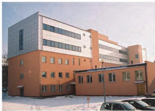
Надстройка на крыше в процессе строительно-монтажных работ Здания с 2мя дополнительными этажами после реновации
