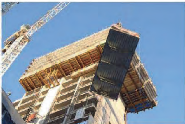
Подъем модулей системы Hi-point на крышу краном
