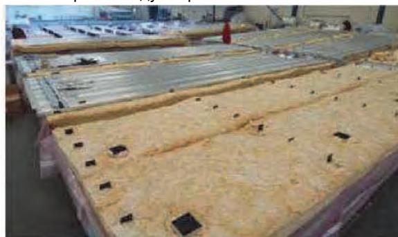
Модуль крыши с установленной теплоизоляцией
