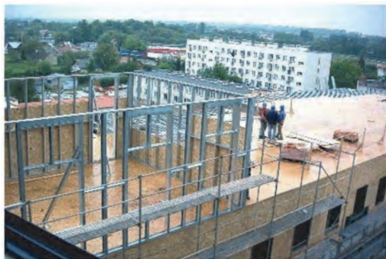
Надстройка на крыше в процессе строительно-монтажных работ Здания с 2мя дополнительными этажами после реновации
