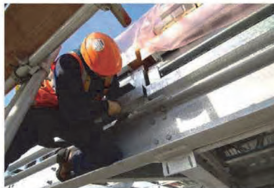
Фиксация модулей системы Hi-point болтами на стальном несущем каркасе крыши
