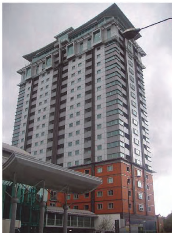
Рис. 2.1. Примеры установки новых фасадных систем на старые фасады зданий с бетонными стеновыми панелями. Новые фасадные системы состоят из горизонтальных металлических панелей
