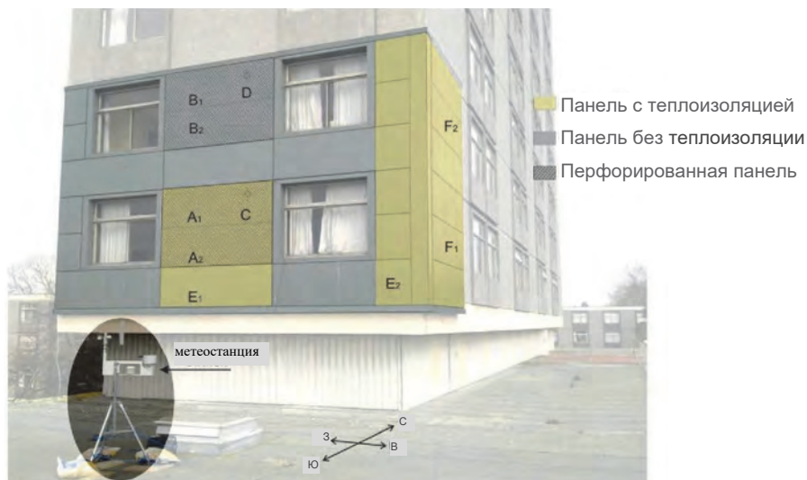
Рис. 3.12. Местоположение перфорированных панелей на южной стороне здания
