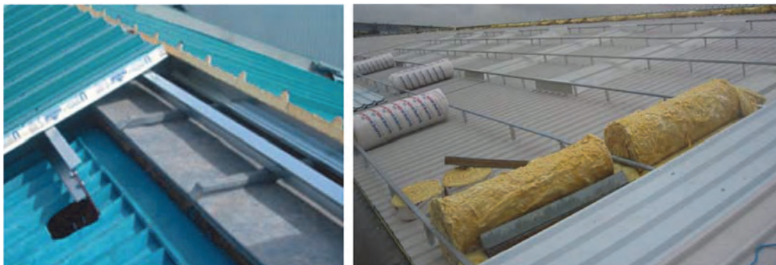
Рис. 4.27. Установка новой крыши с использованием композитных панелей (слева) и сборной кровельной системы (справа) поверх старой
