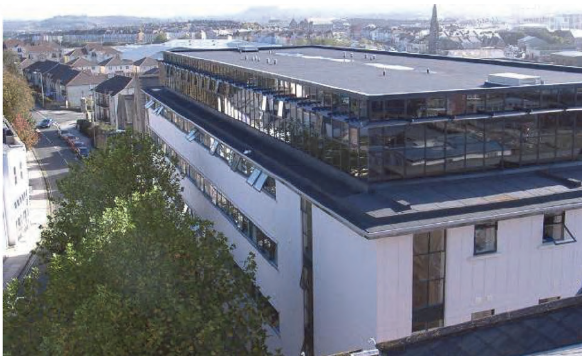
Рис. 2.3. Надстройка из модулей на здании Плимутского университета, Великобритания
