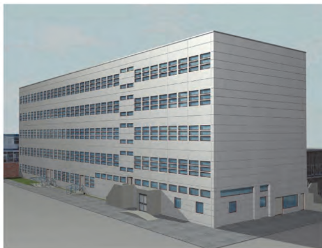
Рис. 3.1. Внешний вид здания с новой фасадной системой из больших стальных кассетных панелей.
