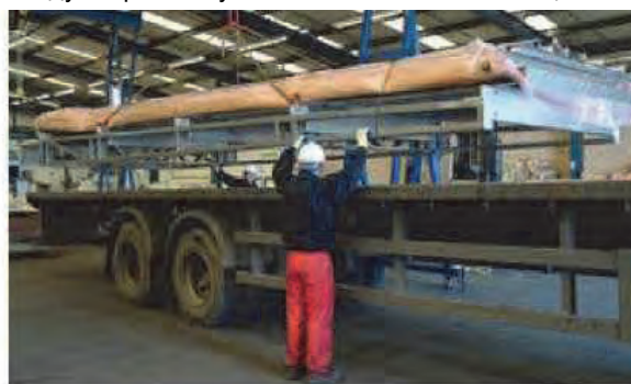
Модуль крыши готовый к отправке на объект
