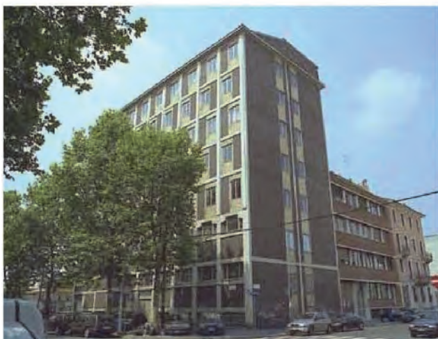
Фото здания до реновации
