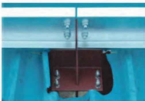
Отверстие в крыше и новый кляммер, прикрепленный к стропилу
