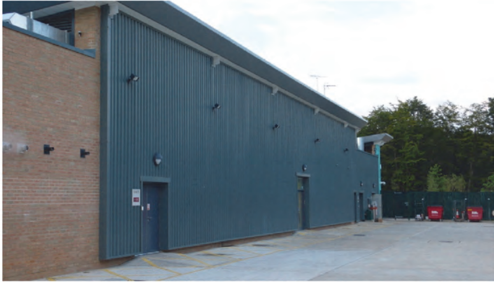
Рис. 3.18. Перфорированный солнечный коллектор типа SolarWall® на южной стене АЗС города Биконсфилд (Великобритания), подогревающий воздух для системы вентиляции фуд-корта
