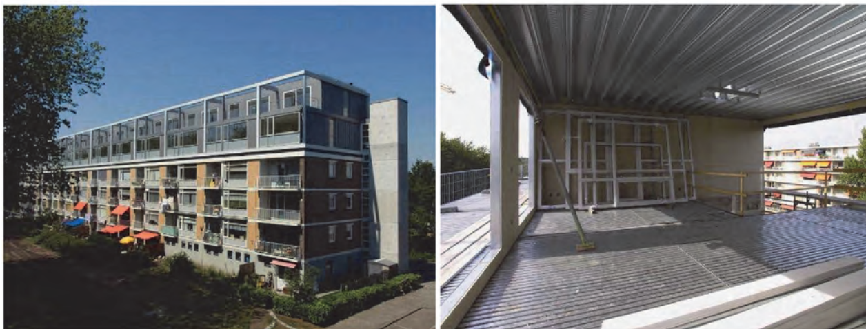
Рис. 2.2. Двухэтажная надстройка из легкого стального каркаса на существующем здании, Роттердам
