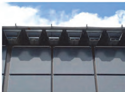
Здание с крышей VTT. Уклон крыши составляет примерно 30°, на южной стороне. Воздушные каналы в профилированном листе.
