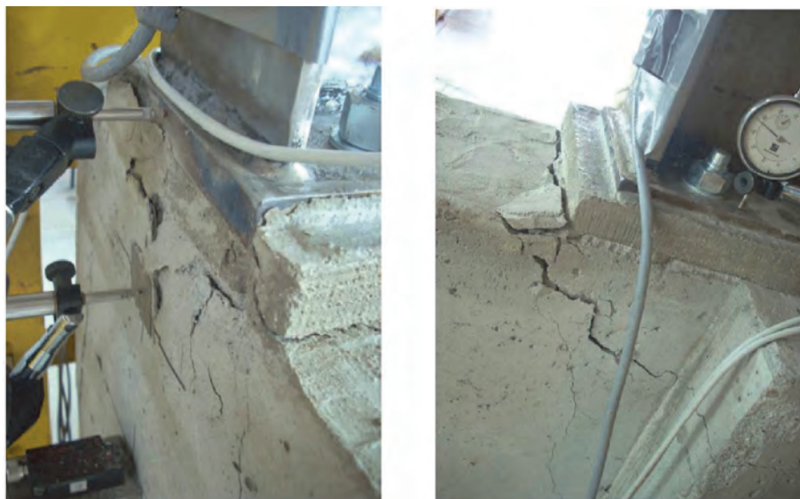
Рис. 5.18. Модели разрушения бетонного основания
