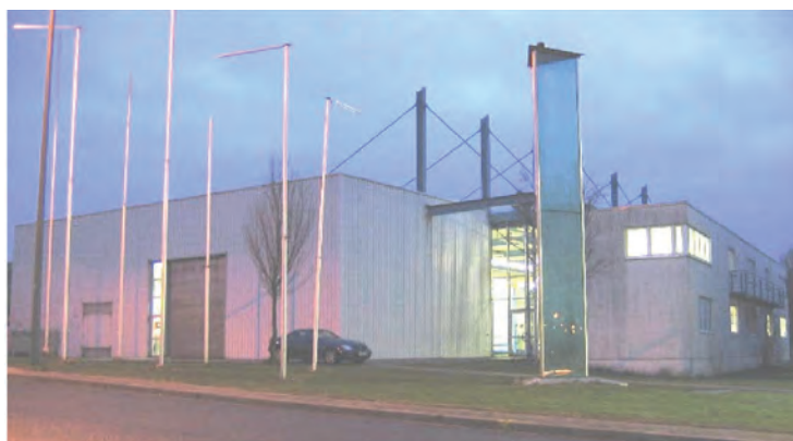
Рис. 4.1. Здание Рейнско-Вестфальского технического университета (RWTH) — южный фасад
