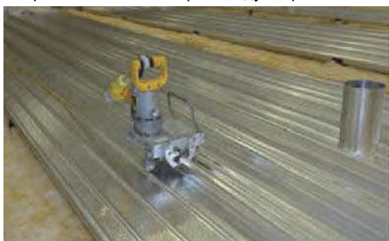
Модуль крыши с установленным кровельным материалом
