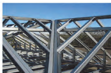
Трансформация плоской крыши и создание дополнительного обитаемого пространства под ней с помощью легких стальных конструкций
