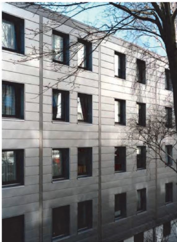
Рис. 2.1. Примеры установки новых фасадных систем на старые фасады зданий с бетонными стеновыми панелями. Новые фасадные системы состоят из горизонтальных металлических панелей
