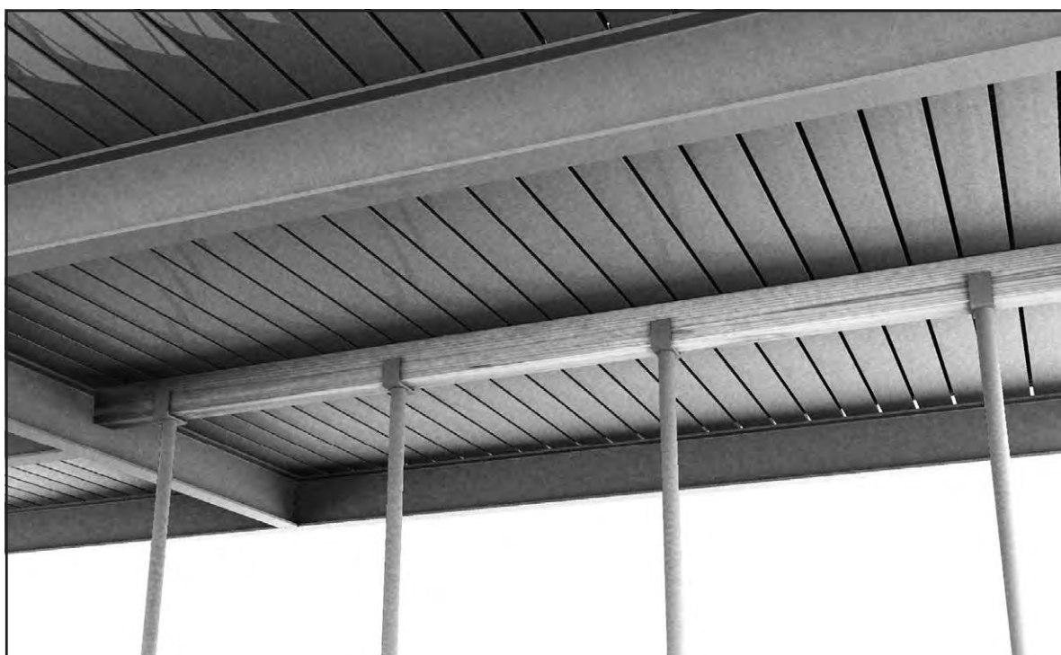
Рис. 4.17. Временные опоры с использованием технологии Acrow
