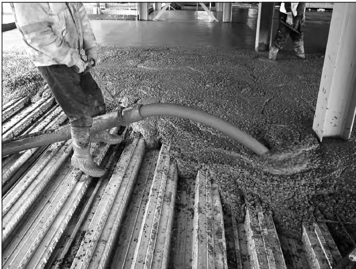
Рис. 6.4. Подача фибробетона бетононасосом
