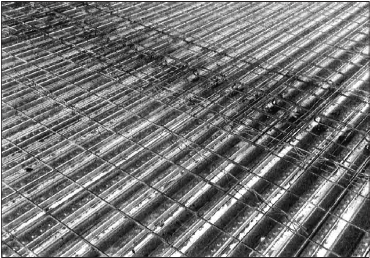
Рис. 6.3. Настил и арматурная сетка — готовое к бетонированию перекрытие
