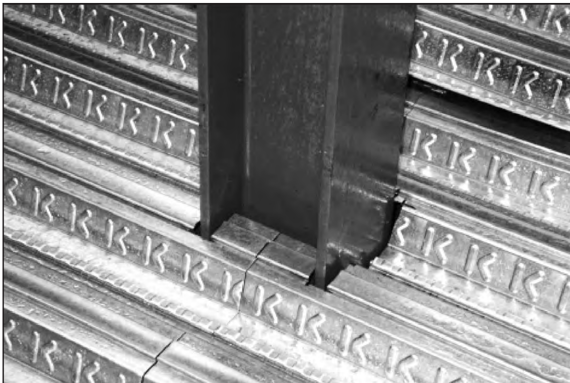
Рис. 4.9. Пример укладки настила при пересечении с колонной
