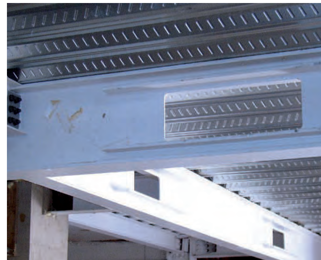
Рис. 1.1 Изолированные прямоугольные отверстия в ком- бинированной балке
