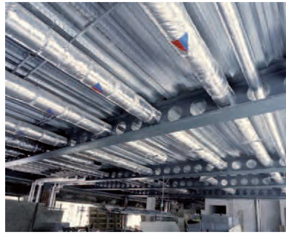
Рис. 1.2 Перфорированная балка с регулярно расположенными круглыми отверстиями, которая образована из двух горячекатаных профилей
