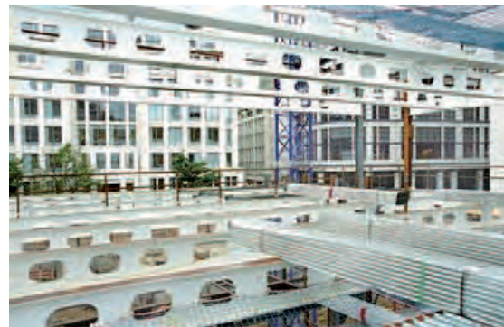
Рис. 1.3 Балки, изготовленные из трех пластин, с отверстиями разной формы
