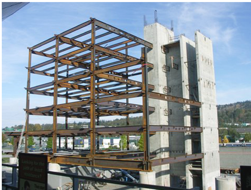
Рисунок 9 Пример многоэтажного стального каркаса с монолитным железобетонным ядром
