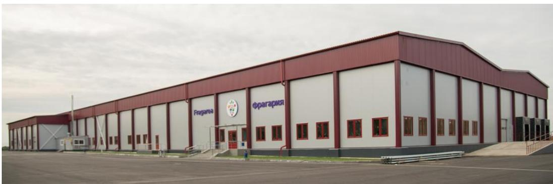
Рис. 6.4 – Здание глубокой заморозки и переработки ягод «Фрагария» [6] г. Липецк с наружным каркасом из стальных холодногнутых профилей
