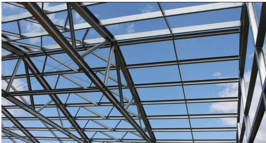
**Рамные несущие стальные конструкции из тонкостенных оцинкованных профилей
