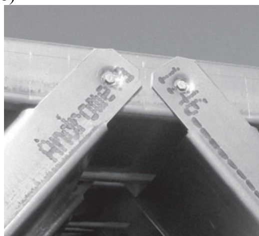
Рисунок 12.2 – Сопряжение элементов каркаса
