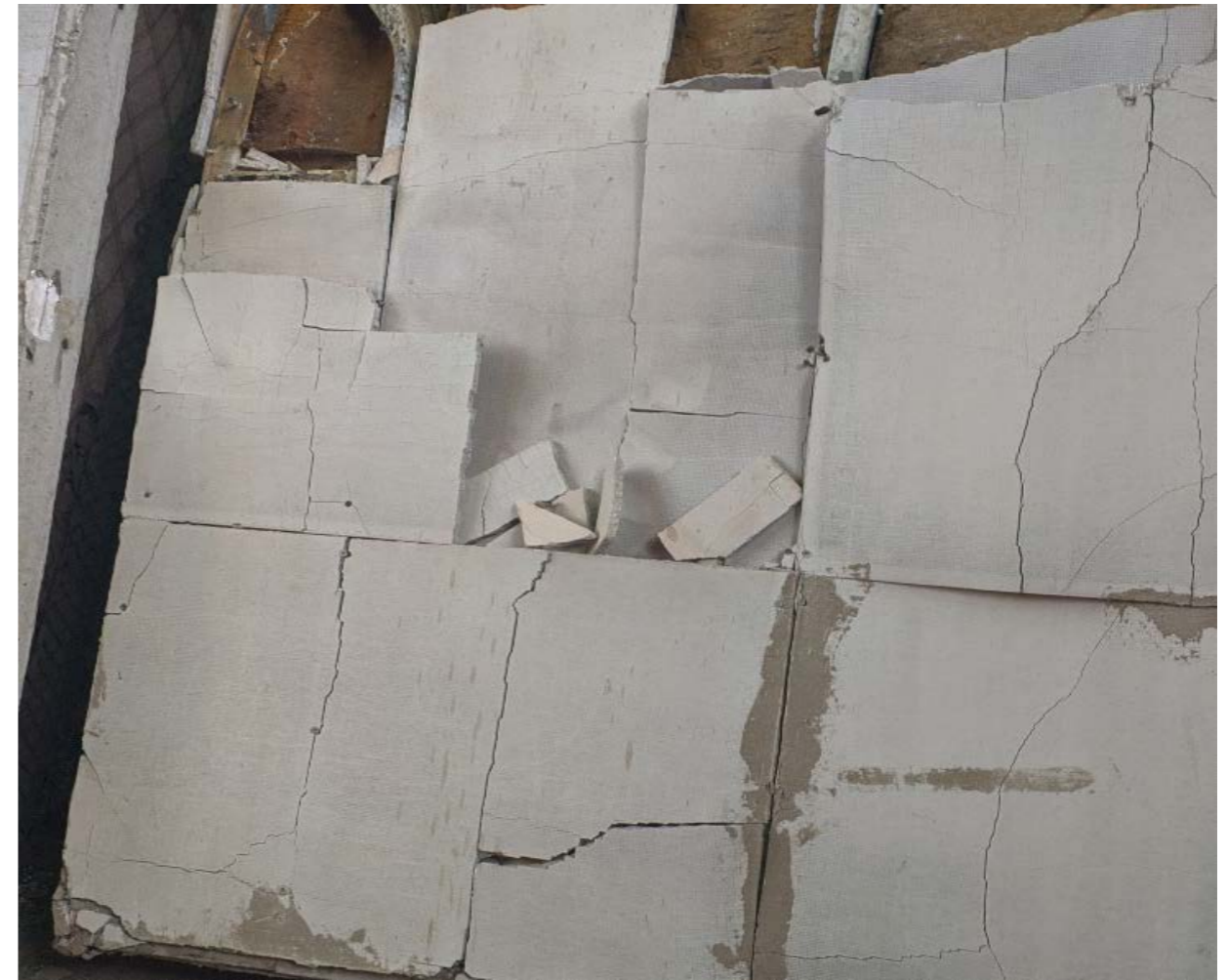
Растрескивание панелей по точкам креплений
