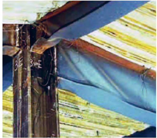
Рис. 3.5.6. Потеря местной устойчивости полки и стенки балки
