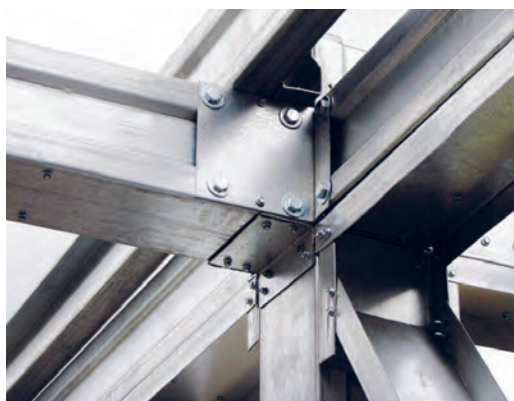
Рис. 8.3.9. Общий вид узлов конструкции с применением ЛСТК
