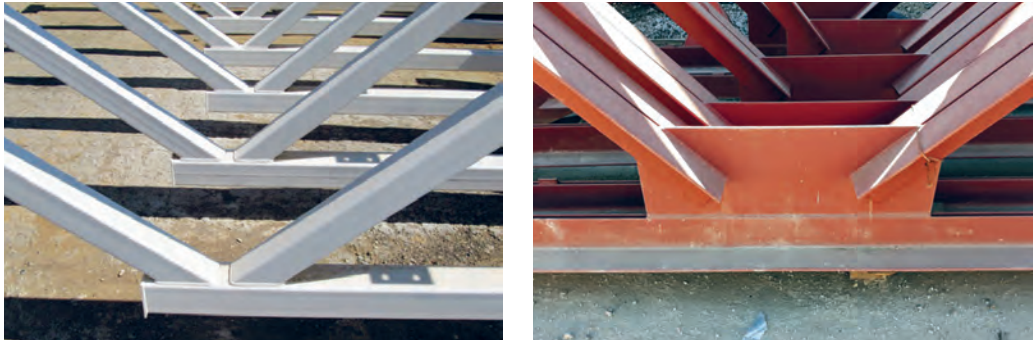
Рис. 2.1.4. Узлы ферм
