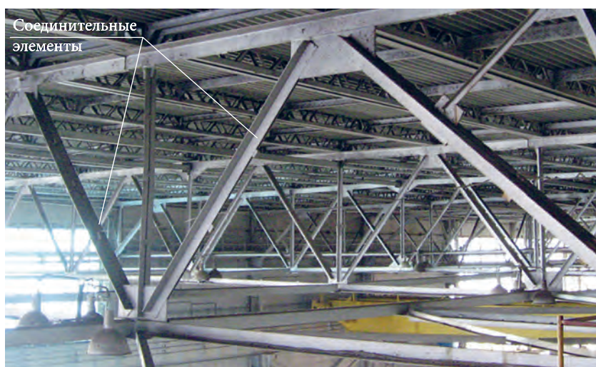
Рис. 5.3.3. Соединительные элементы в фермах из парных уголков
