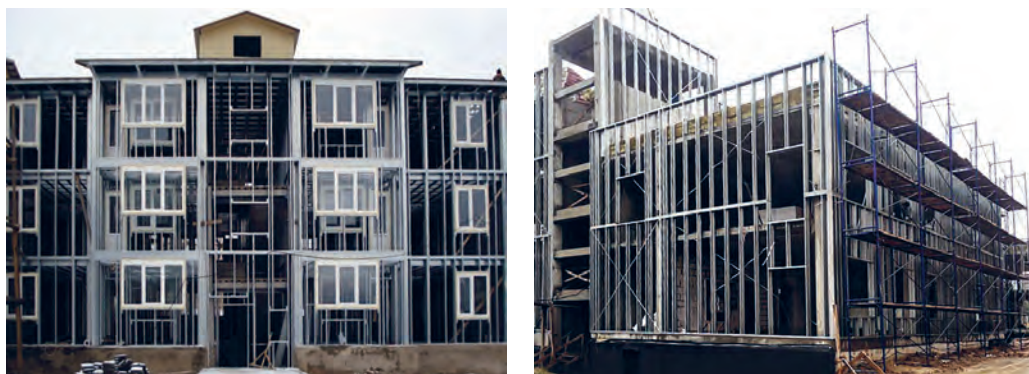
Рис. 8.3.11. Несущие и ненесущие КОС в каркасных зданиях:
