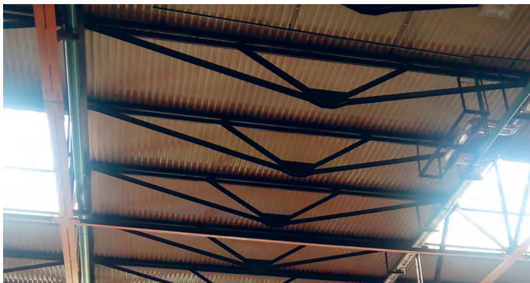
Рис. 5.2.2. Шпренгельные прогоны покрытия
