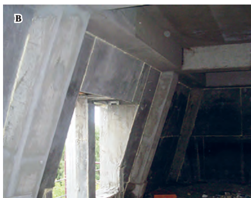
Рис. 8.4.1 Пример мансардных ЛСБК: а) несущий каркас из профильной стали; б) установка листового материала; в) общий вид ЛСБК
