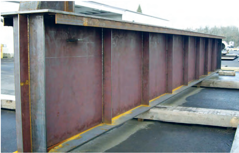
Рис. 3.5.8. Балка с поперечными ребрами жесткости
