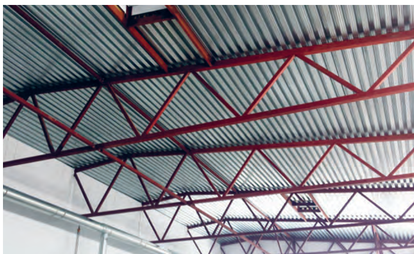
Рис. 5.3.4. Беспрогонное покрытие
