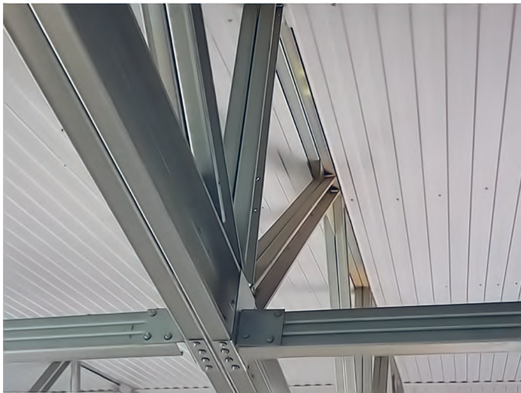
Рис. 8.3.1. Ферма на основе ЛСТК (пролетом 24 м)
