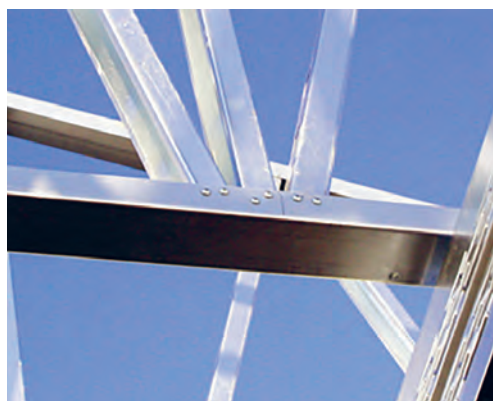
Рис. 8.3.9. Общий вид узлов конструкции с применением ЛСТК
