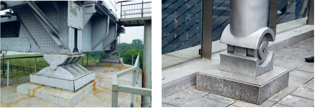
Рис. 2.1.2. Шарнирные опоры
