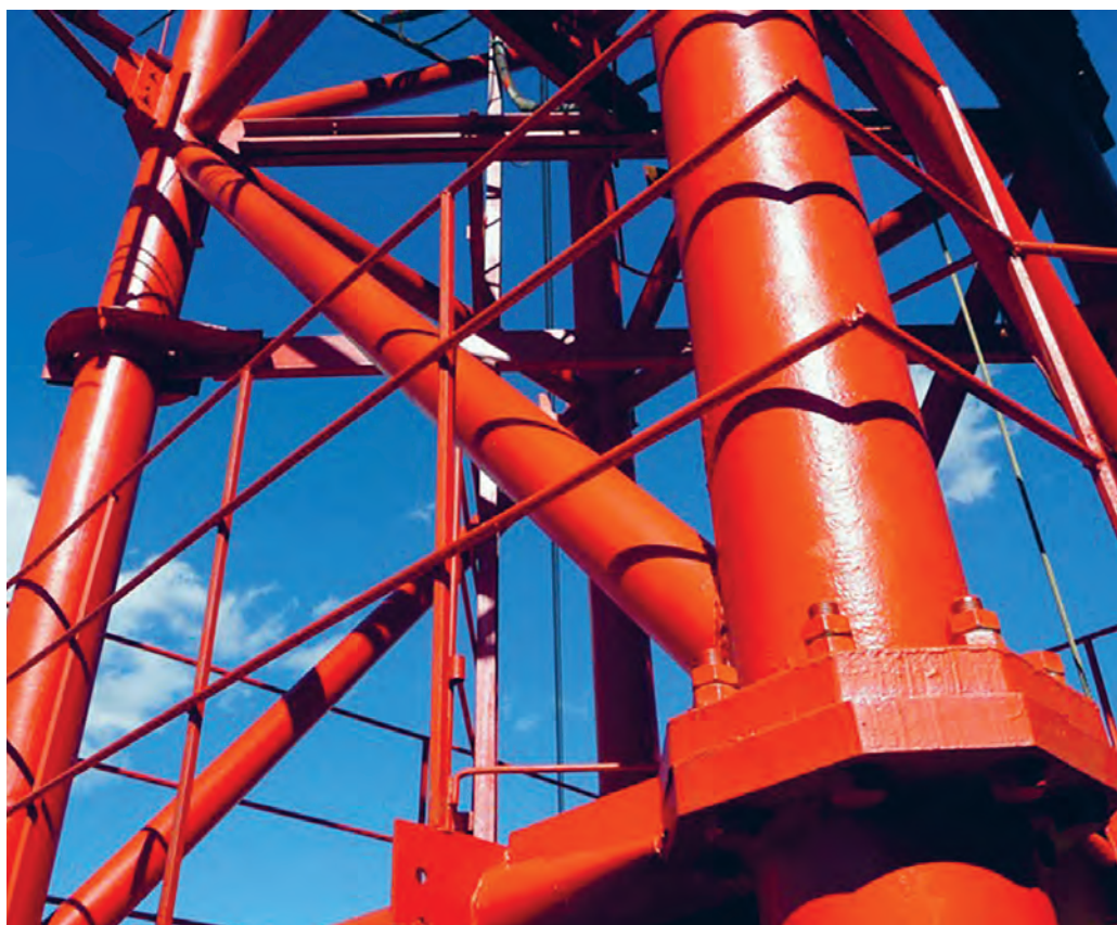
Рис. 1.6.8. Пример металлоконструкции с использованием труб большого диаметра
