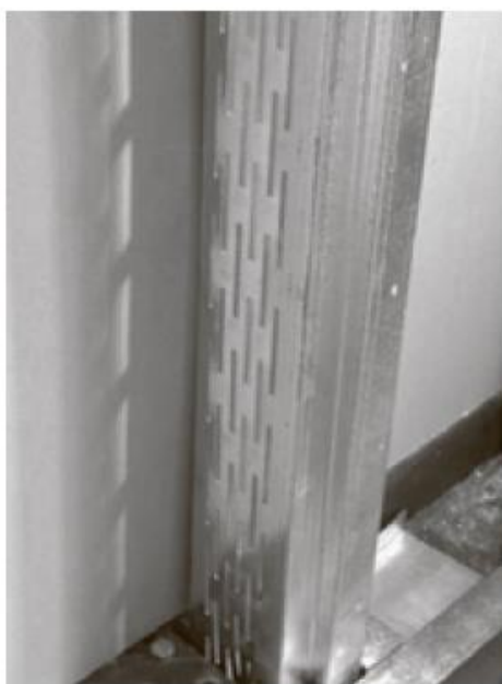
Неравномерное опирание
