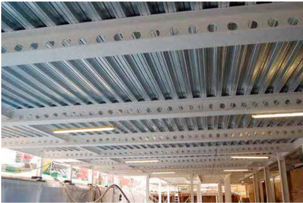
12-метровый пролёт перекрыт перфорированными балками
