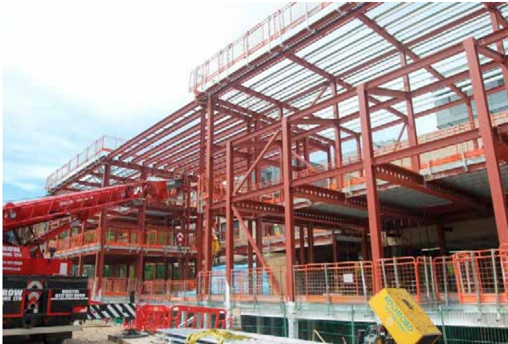
Каркас пристройки работает независимо от существующего здания
