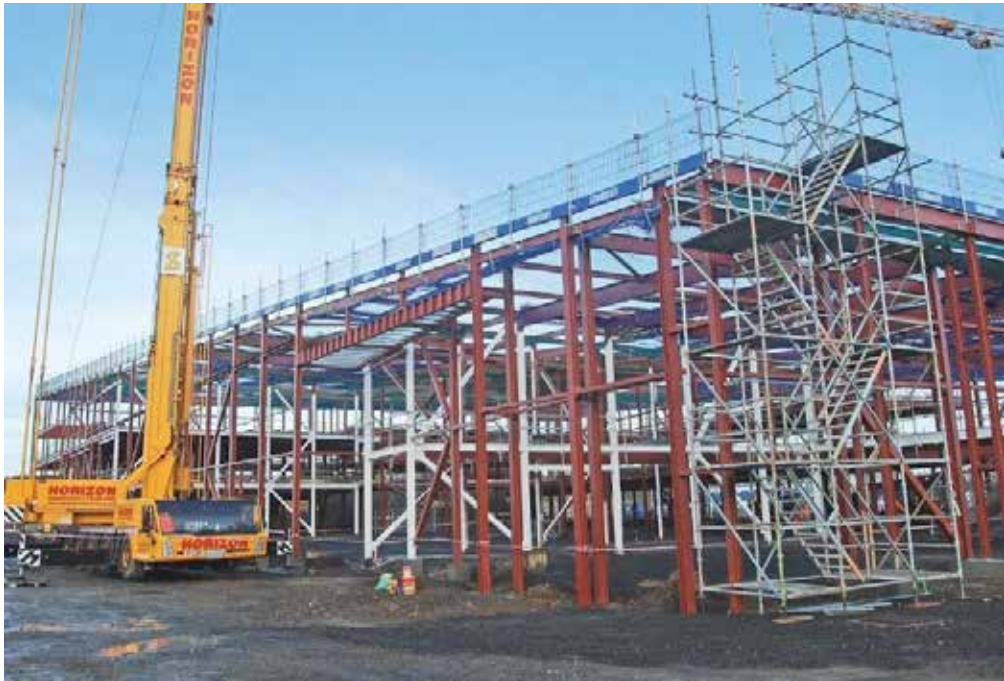
Монтаж основных конструкций здания
