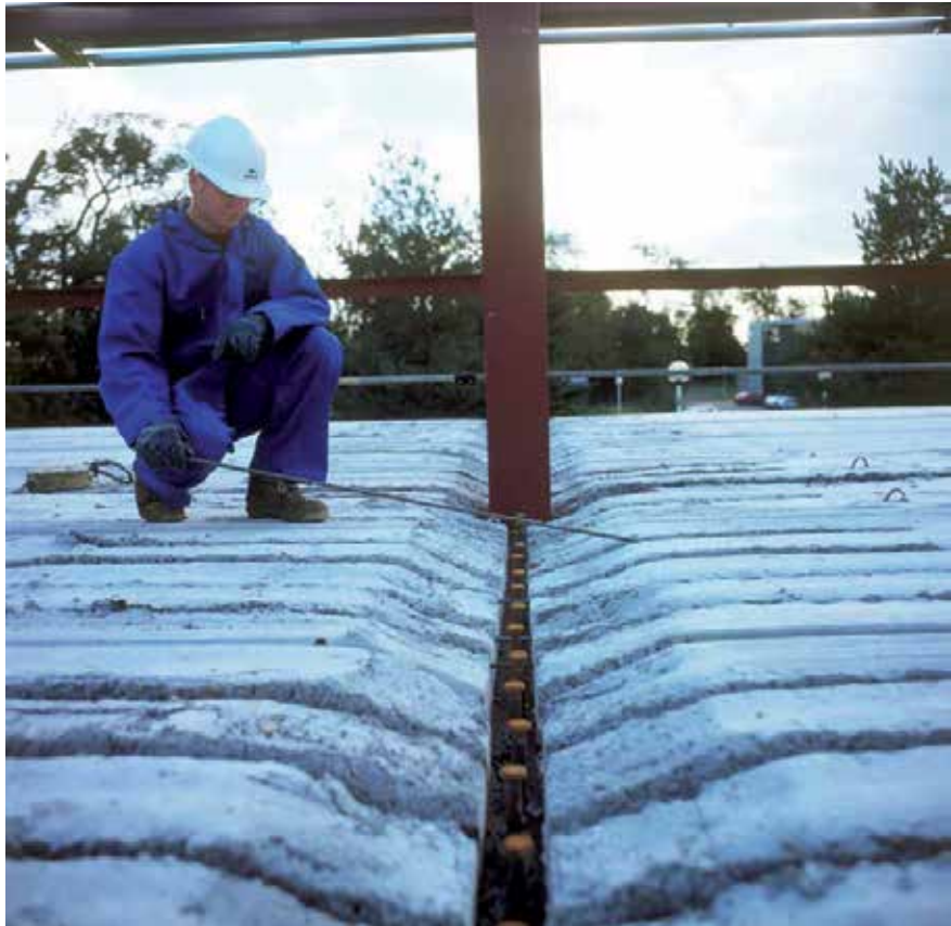
Рисунок 12 Усечённые края сборных плит и анкерные упоры, приваренные к стальной балке
